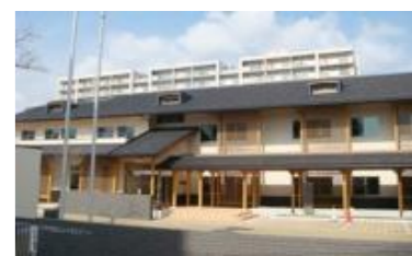
西宮こども家庭センター(西宮市青木町)
